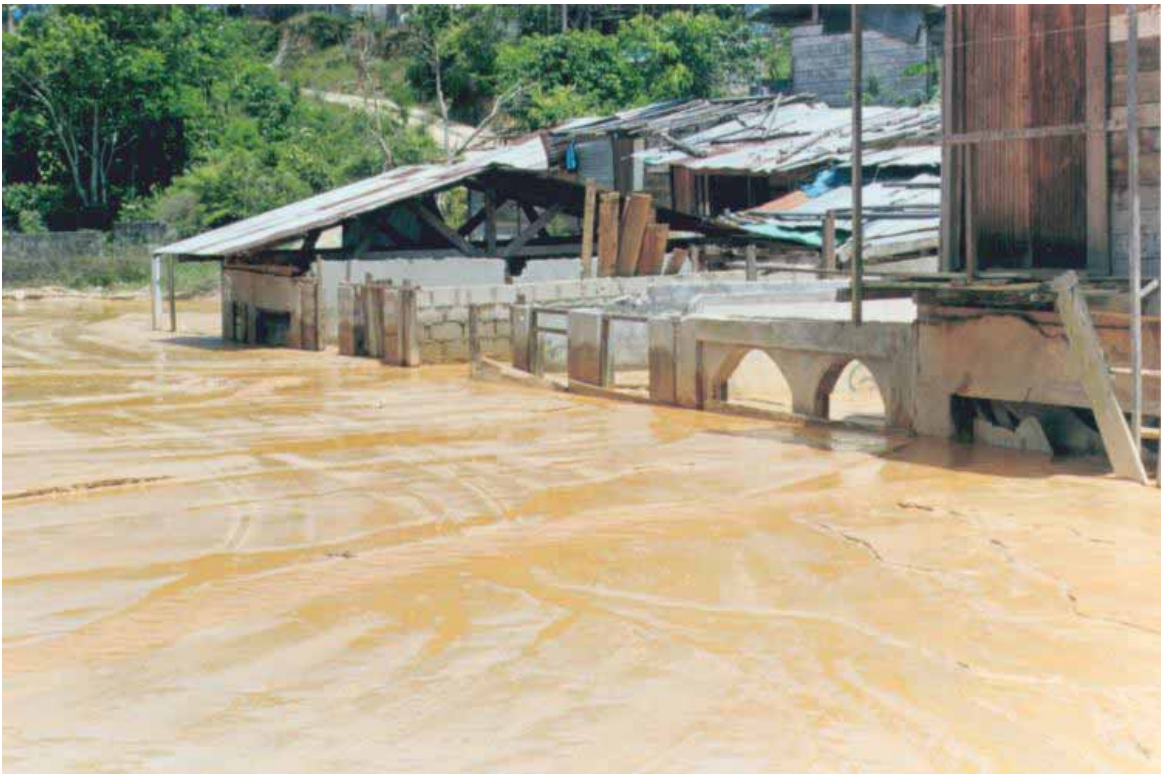
Foto 16: Problemas de inundación y sedimentación, en una calle de Huaypetuhe, generados por la actividad aurífera.
